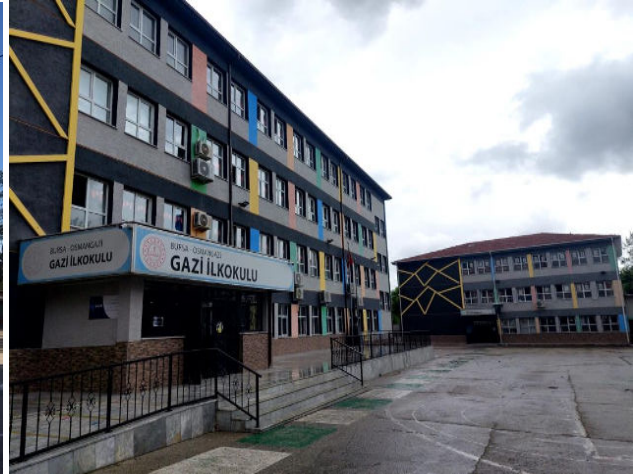
Deprem Güçlendirmesi Sonrası
